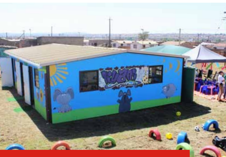
Am Ende des Einsatzes steht ein neues, einladendes Kita-Gebäude
